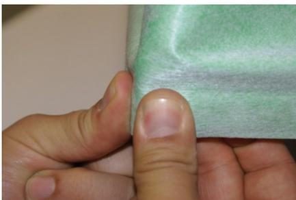
Anformungen aus Butylknetmasse besonders sorgfältig an den innenliegenden Butylstreifen anmassieren.
