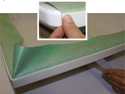
Schalldämmstreifen ankleben. Einbauhöhe ist Unterkante obere Wannenrundung.
