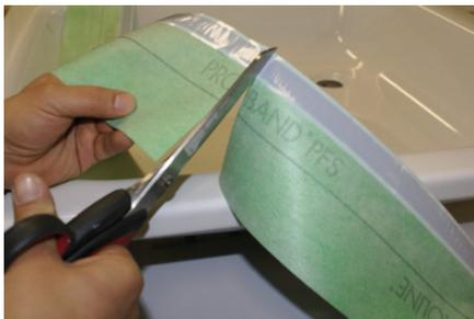
PROFOLIO Wannendichtband auf die Länge der Andichtfläche zuschneiden. Stöße vermeiden!
