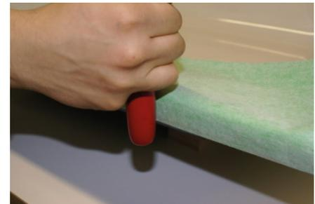
Mit glattem, stabilen Werkzeug das Band mit dem Butylstreifen kräftig an die Andichtfläche anreiben. **VORSICHT!** Band nicht beschädigen!
